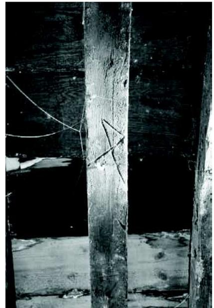
Fig. 5 - Bruges, 4, Kraanplein, solive du plafond du rez-de-chaussée, marquée d'un demi-pentagramme.
