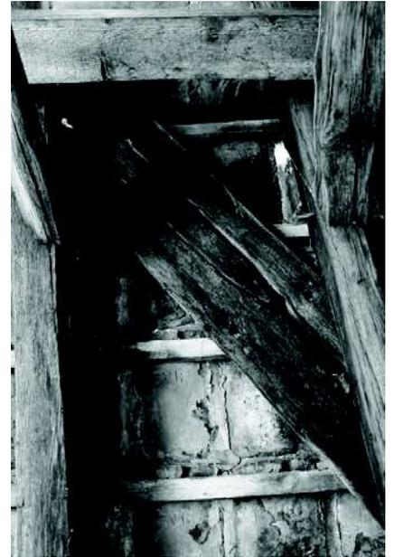
Fig. 9 - Bruges, 4, Kraanplein, écharpe du versant occidental de la charpente, remploi de bois construction navale?
