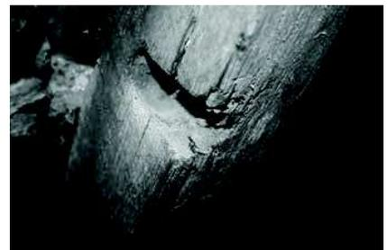
Fig. 6 - Bruges, 4, Kraanplein, trou de radeau scié transversalement, sur un chevron de la charpente.
